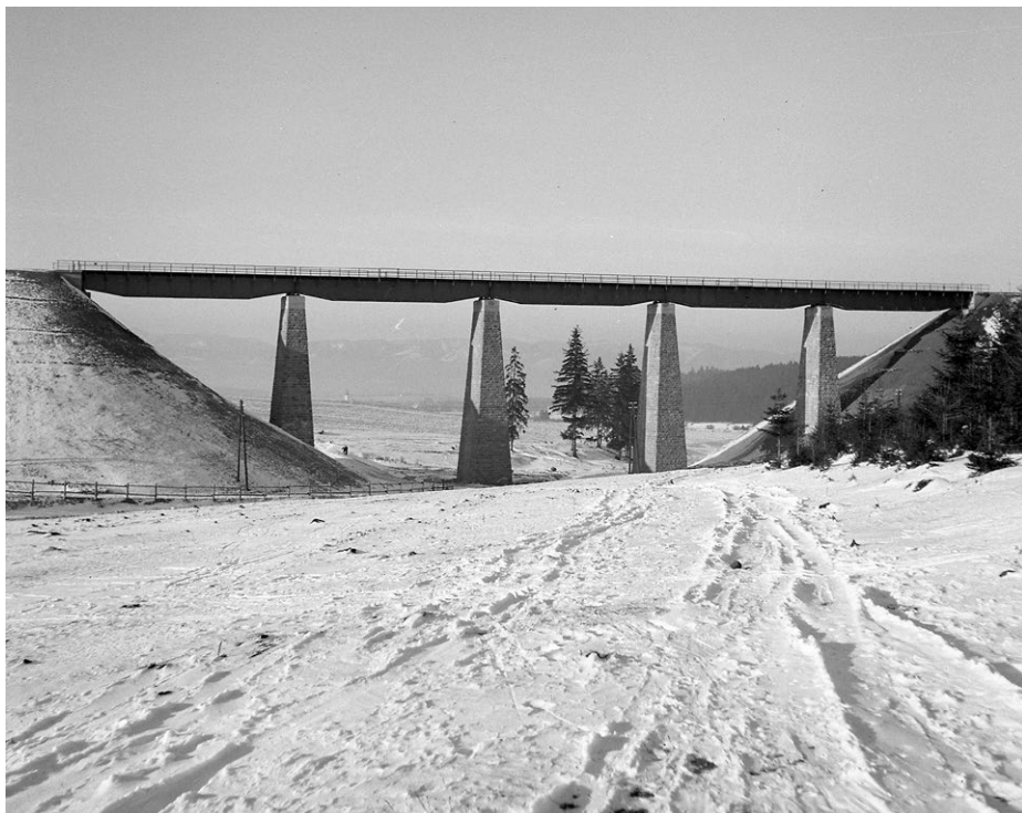
Most na železniční trati Banská Bystrica – Dolná Štubňa. Zdroj: SNA, f. STK, č. SK_1510_29443_06207.
