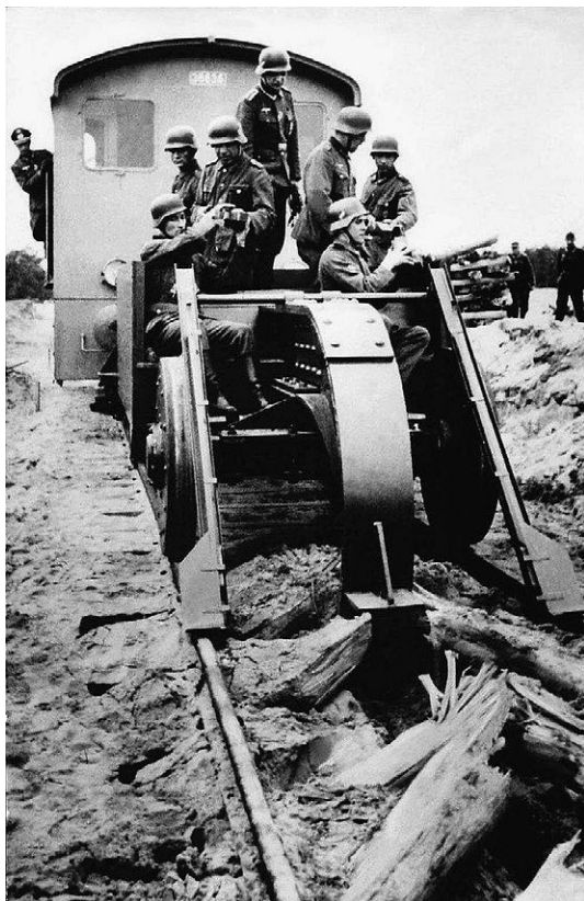
Německé jednotky přivezly na ničení železničních tratí speciální vůz, který vytrhával a přeřezával koleje. Zdroj: archiv Miroslava Sabola.
