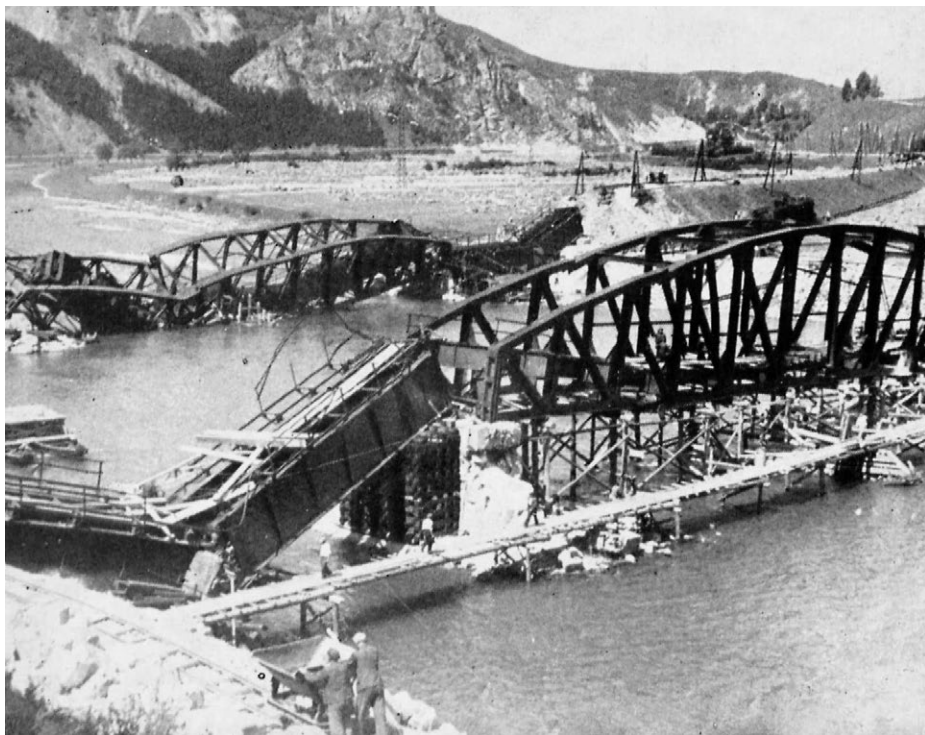
Železniční most u Strečna (Žilina) 1945 po přechodu fronty. Zdroj: stavební společnost Tvorba, bulletin 1945.
