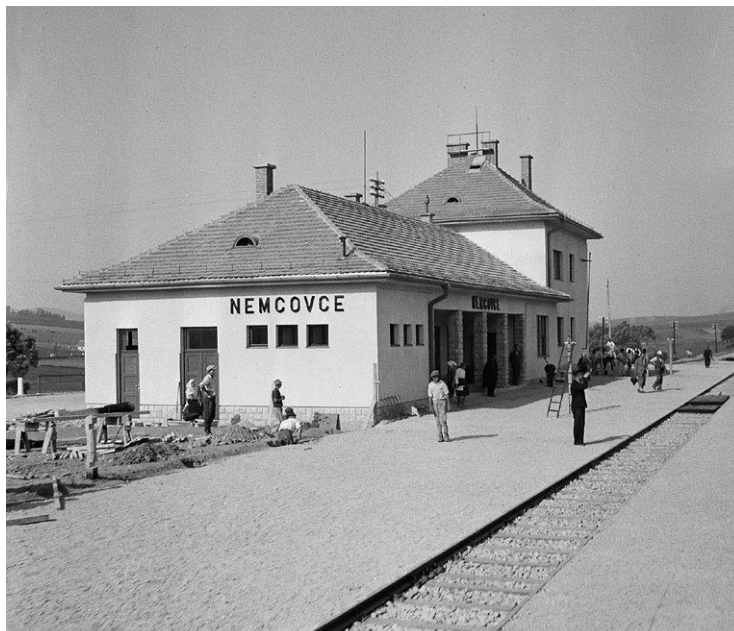
Jedna z moderních staničních budov Nemcovce na trati Prešov – Strážske. Zdroj: SNA, f. STK, č. SK_1510_29443_21564.
