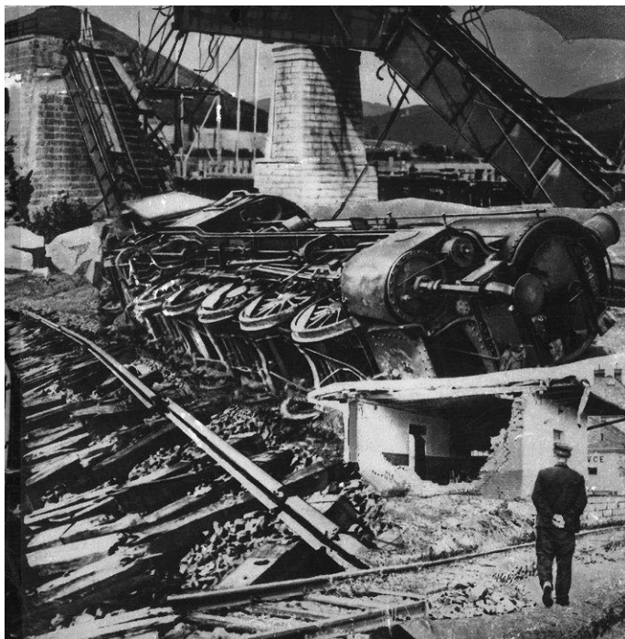
Infrastruktura na Slovensku po válce byla značně zdevastovaná. Zdroj: Rekonštrukcia železnic na Slovensku , Bratislava 1946.
